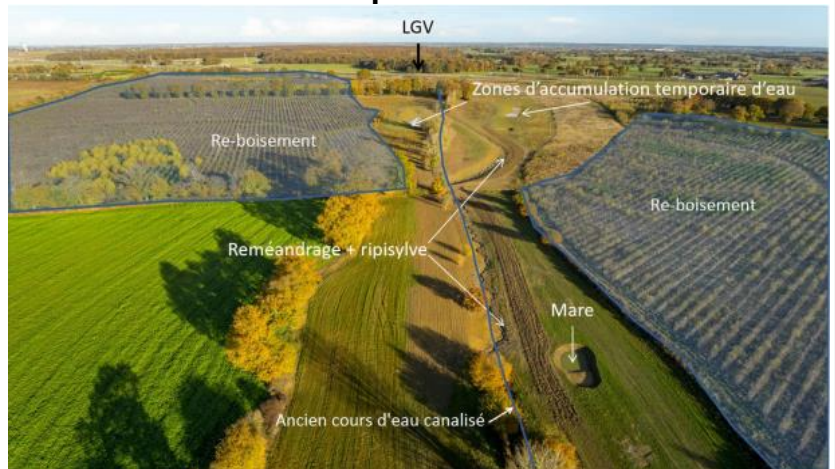
Photographie après mise en oeuvre de la mesure compensatoire
